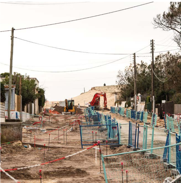
Travaux avenue de l'Océan
