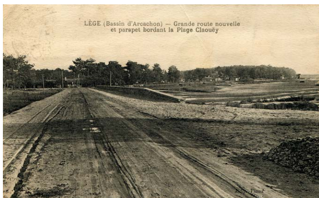
Claouey - Grande route nouvelle et parapet bordant la plage (fonds François Bisch).
